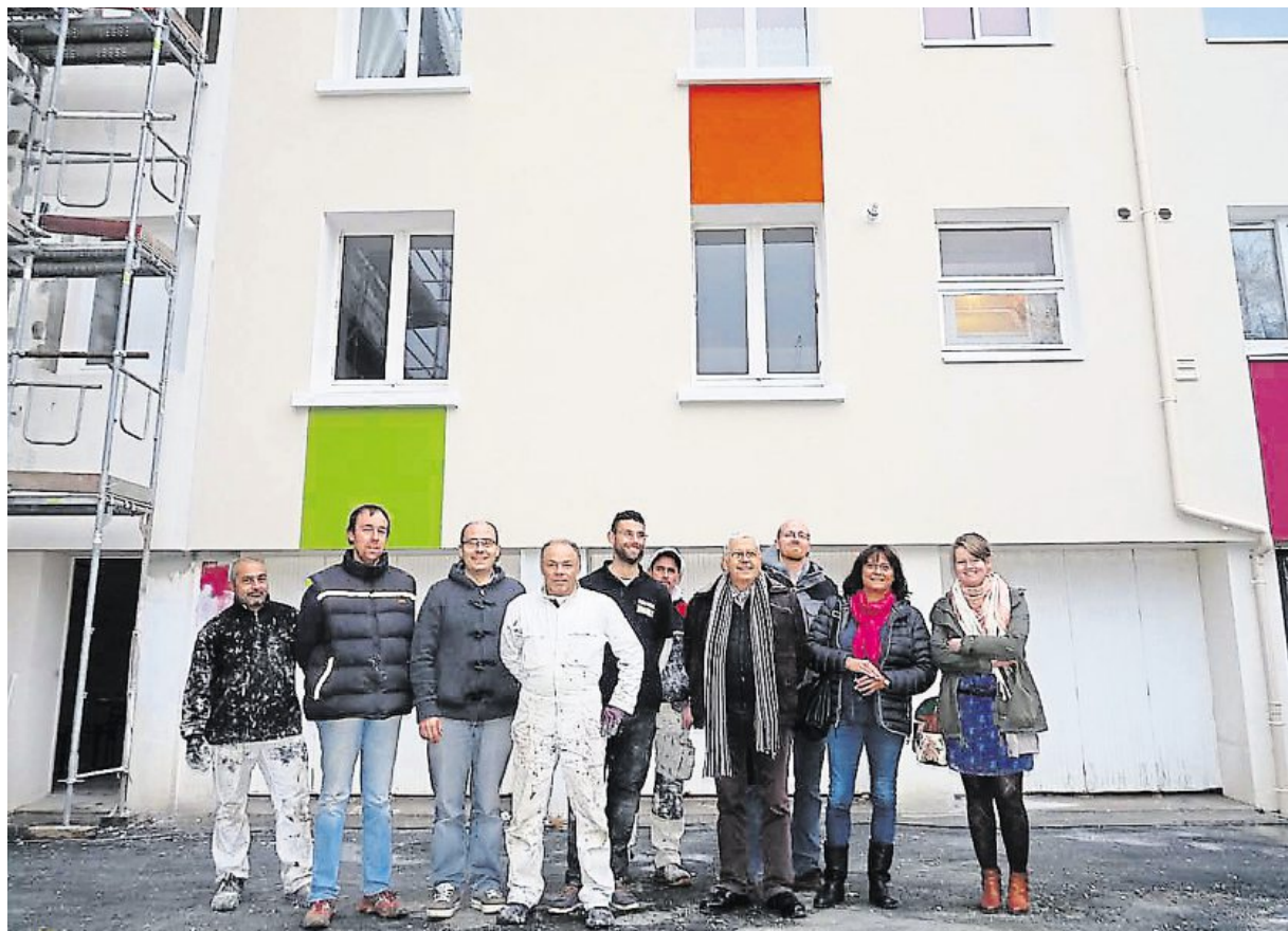
Une copropriété privée de la rue Duhamel, dans le secteur du Valy-Hir, a bénéficié de travaux de rénovation dont une isolation thermique par l'extérieur.
