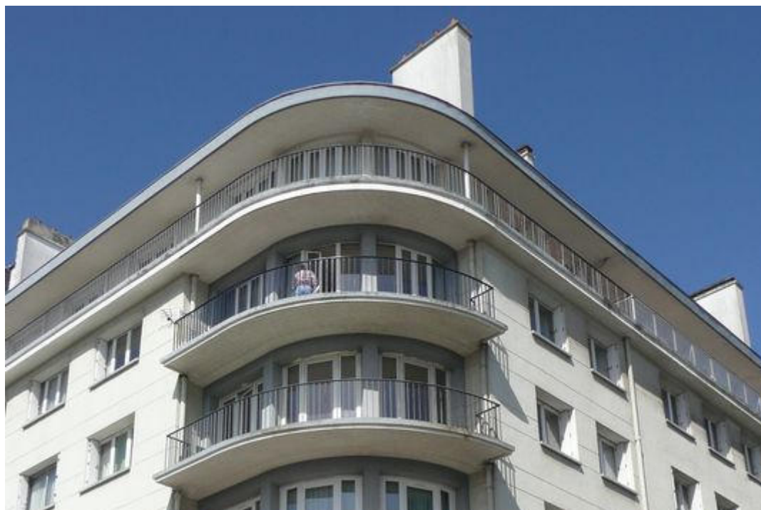
Un immeuble brestois construit dans les années 1950. ADEUPa de Brest / ADEUPa de Brest
