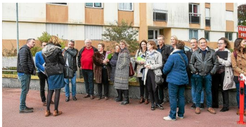
Après la présentation des projets en mairie de Bellevue, mardi, élus, techniciens, financeurs et représentants des copropriétaires se sont rendus auprès de la tour de 17 étages située avenue de Tarente. Y ont été évoqués la nature des travaux à réaliser.
